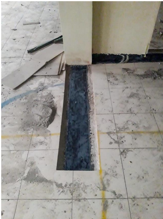
Gambar 3. FRP pada Pelat Gedung
