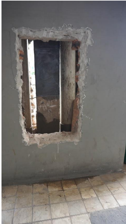
Gambar 4. FRP pada kolom gedung
