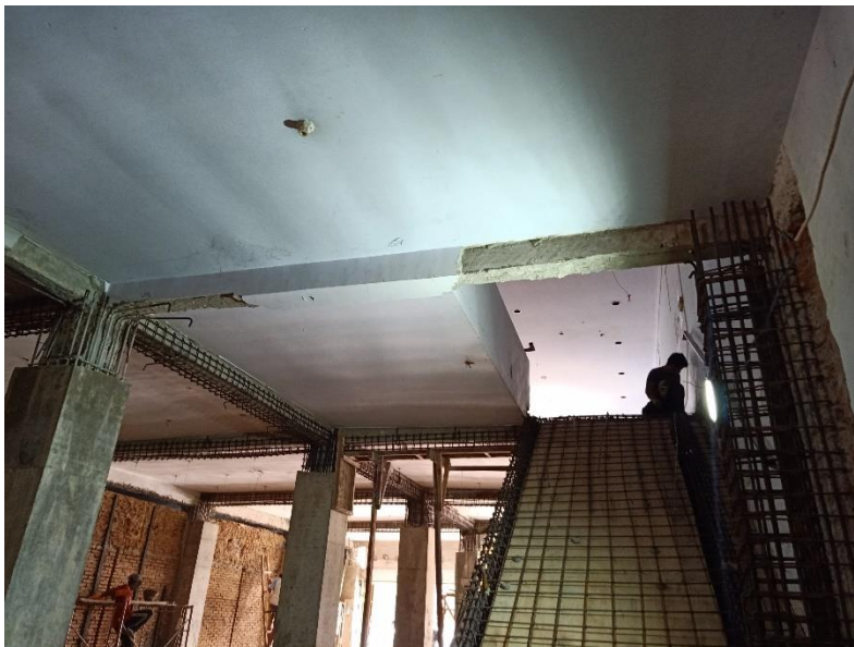
Gambar 1. Perkuatan Struktur Gedung
